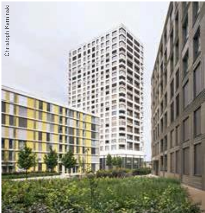
Im Zölly-Tower werden KNX-, DMX- und Voice-over-IP-Technologien genutzt für die Gebäudeautomation.
